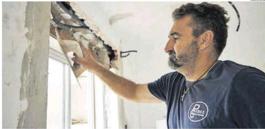
Domingo Pérez, trabajando en una vivienda que está reformando.
